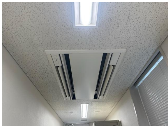
防カビ剤塗布後
