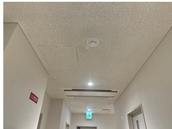
防カビ剤塗布後
