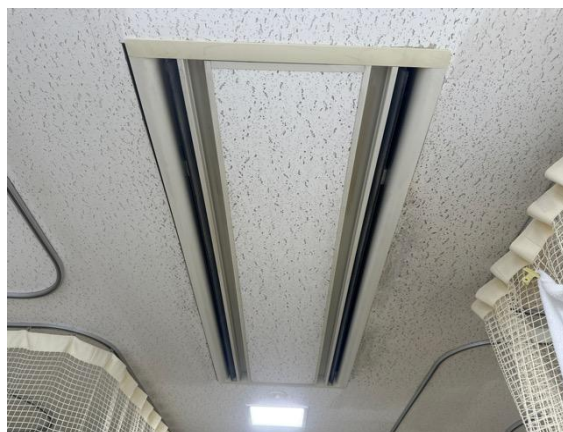
防カビ剤塗布 施工後
