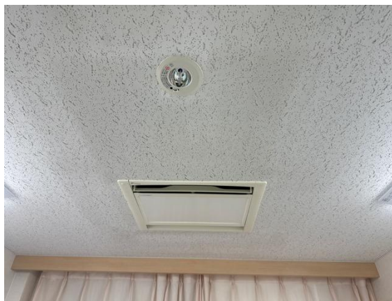
防カビ剤塗布 施工後
