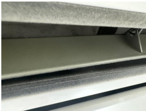
防カビ剤塗布 施行後
